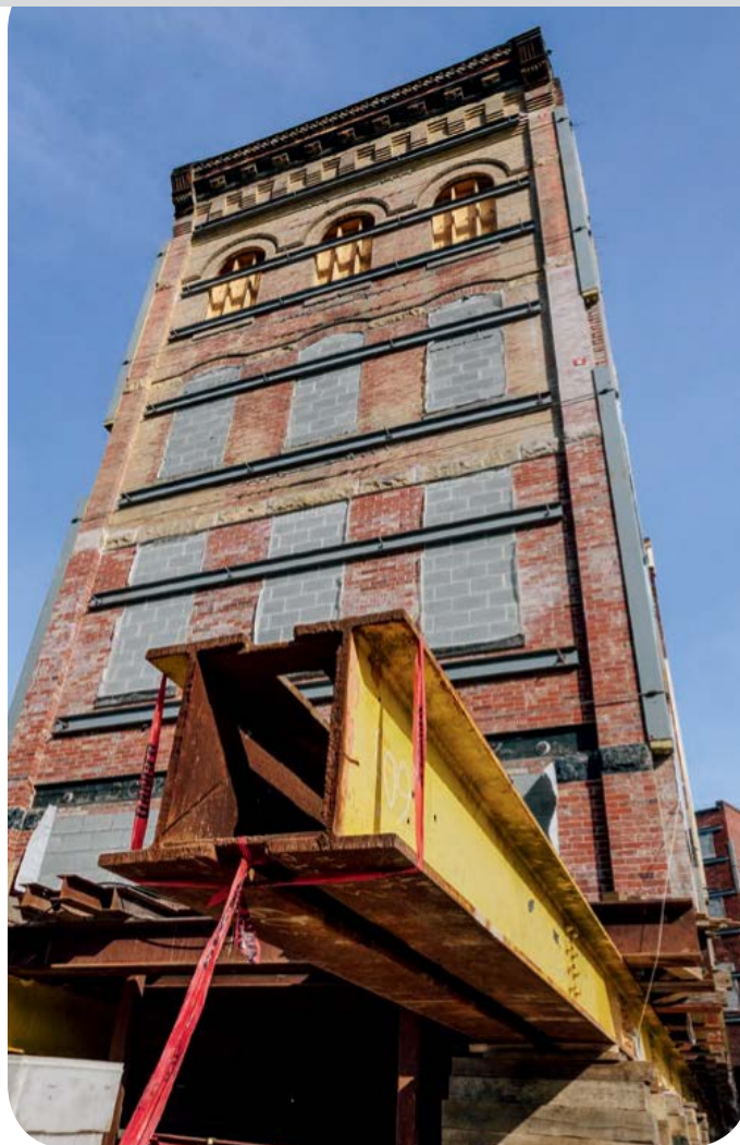
■ Здание при помощи домкратов передвигается на новое место
